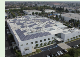
工場屋上に設置されたソーラーパネル
