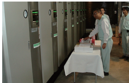
静岡工場新型ボイラーの火入れ式
