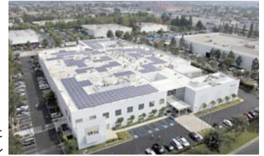
工場屋上に設置された ソーラーパネル
