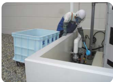
(六甲工場) タンク破損による 化学薬品の流出 防止
