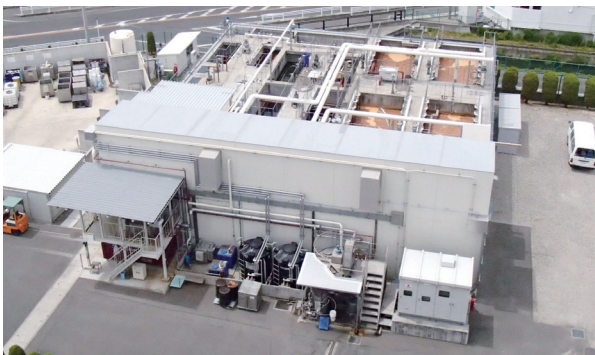
排水処理施設
