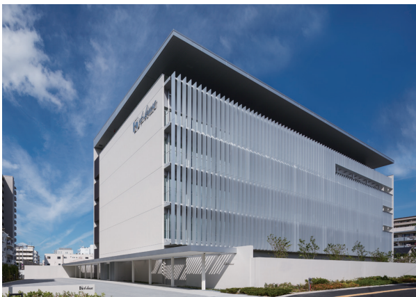
ガラス面に縦方向に入っているのが縦型ルーバー
