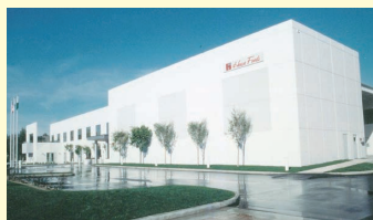
ロスアンゼルス工場 Los Angeles Plant
