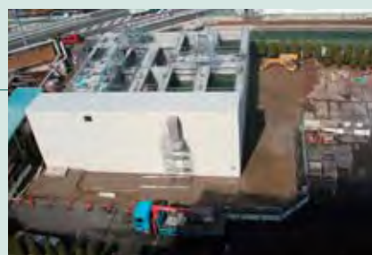
建設中の排水処理設備 (2010年3月撮影)
