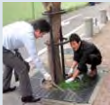
側道の除草作業
