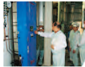
サンハウス食品(株)も新型ボイラーを導入
