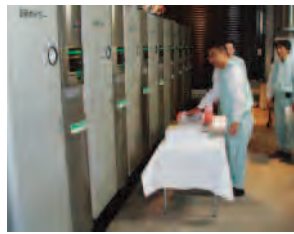
静岡工場新型ボイラーの火入れ式
