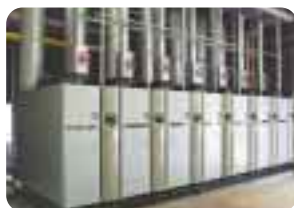
関東工場ボイラー設備
