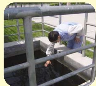
排水処理設備管理状況
